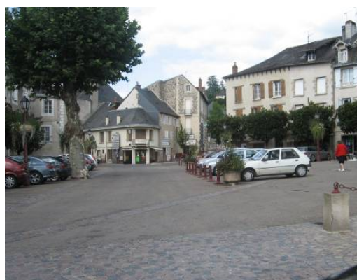
Mise à niveau de l'ensemble de la place dans le centre d'Allasac : la suppression des marquages au sol rend l'automobiliste plus prudent et conscient de la présence d'autres usagers de l'espace public.
